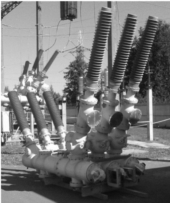
*Рис. 1. КРУЭ PASS MO 145 в транспортном положении*
