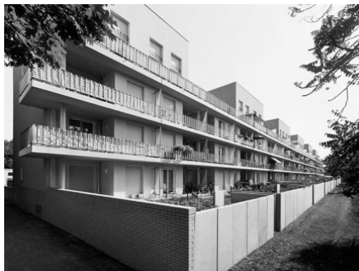
Рис. 1. Реконструкция панельного жилого дома, Германия
