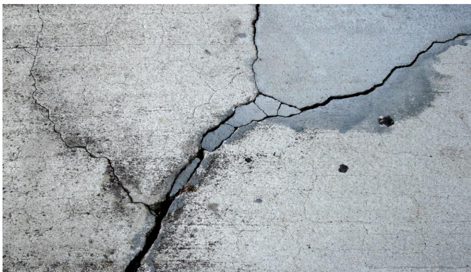
Рис. 6. Трещины бетона
