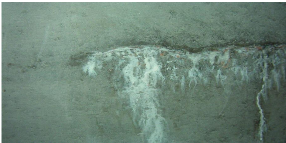
Рис. 5. Выщелачивание бетона
