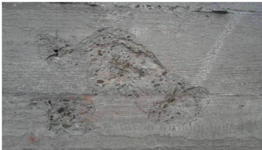
Рис. 2. Отсутствие или недостаточный защитный слой
